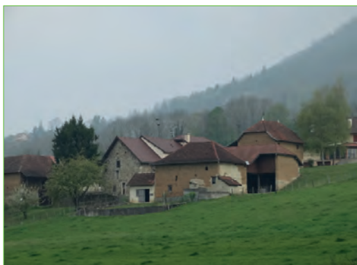
Construction en pisé
